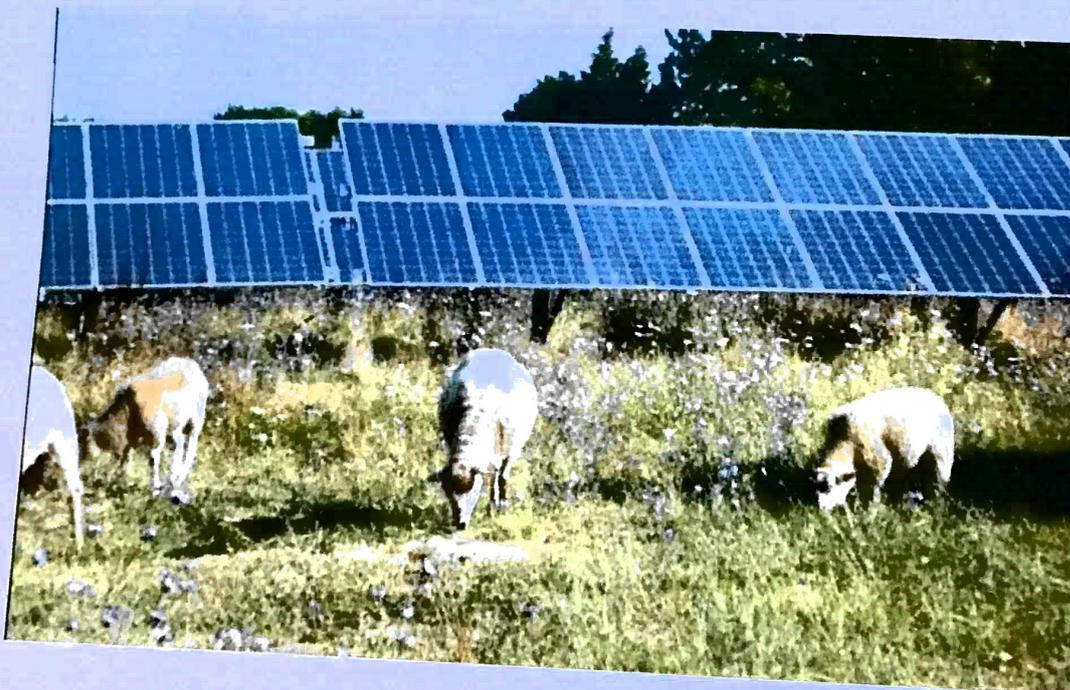
Le parc solaire produira énergie renouvelable sans l'impact environnemental d'autres sources d'énergie. L'installation sera capable de produire 40 MW d'électricité avec une production totale annuelle de 50 GWh. Cela représente une production pour une consommation moyenne annuelle de plus de 2000 Foyers.
